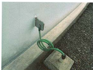
รูปที่ 10 ภาพโดยรวมของสายดินรอบฐานถัง
