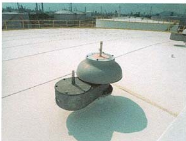
รูปที่ 7 ภาพโดยรวมของอุปกรณ์นิรภัยระบายความ
